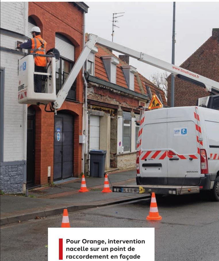
Pour Orange, intervention nacelle sur un point de raccordement en façade pour la mise en service de nouveaux abonnés aux réseaux ADSL et FTTH.
