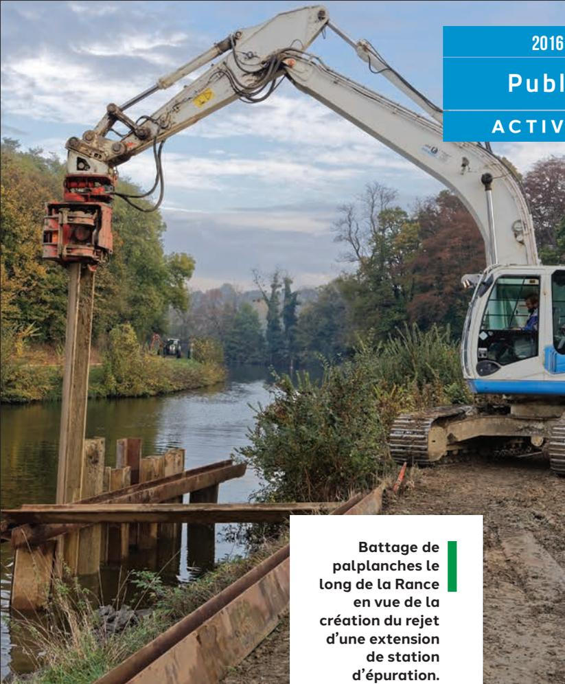
Battage de palplanches le long de la Rance en vue de la création du rejet d'une extension de station d'épuration.
