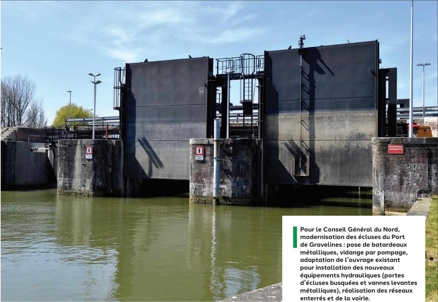
Pour le Conseil Général du Nord, modernisation des écluses du Port de Gravelines : pose de batardeaux métalliques, vidange par pompage, adaptation de l'ouvrage existant pour installation des nouveaux équipements hydrauliques (portes d'écluses busquées et vannes levantes métalliques), réalisation des réseaux enterrés et de la voirie.
