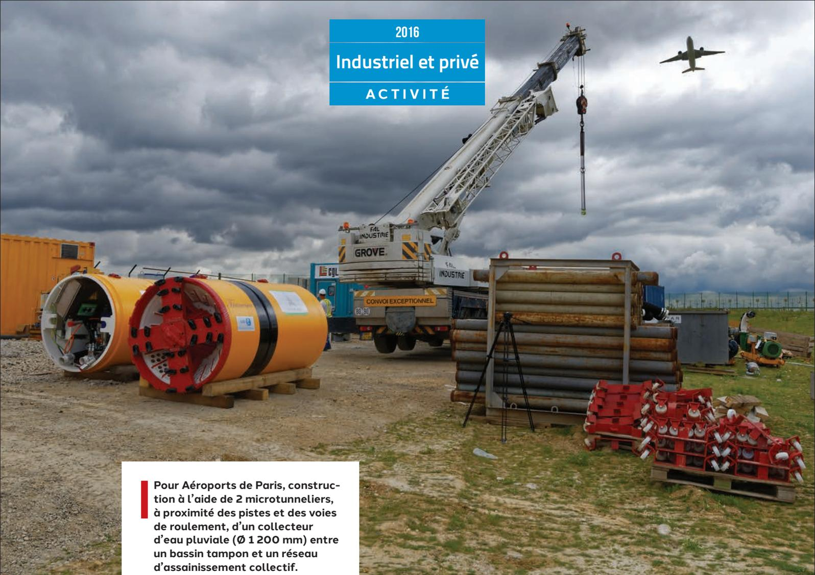
Pour Aéroports de Paris, construction à l'aide de 2 microtunneliers, à proximité des pistes et des voies de roulement, d'un collecteur d'eau pluviale (Ø 1 200 mm) entre un bassin tampon et un réseau d'assainissement collectif.
