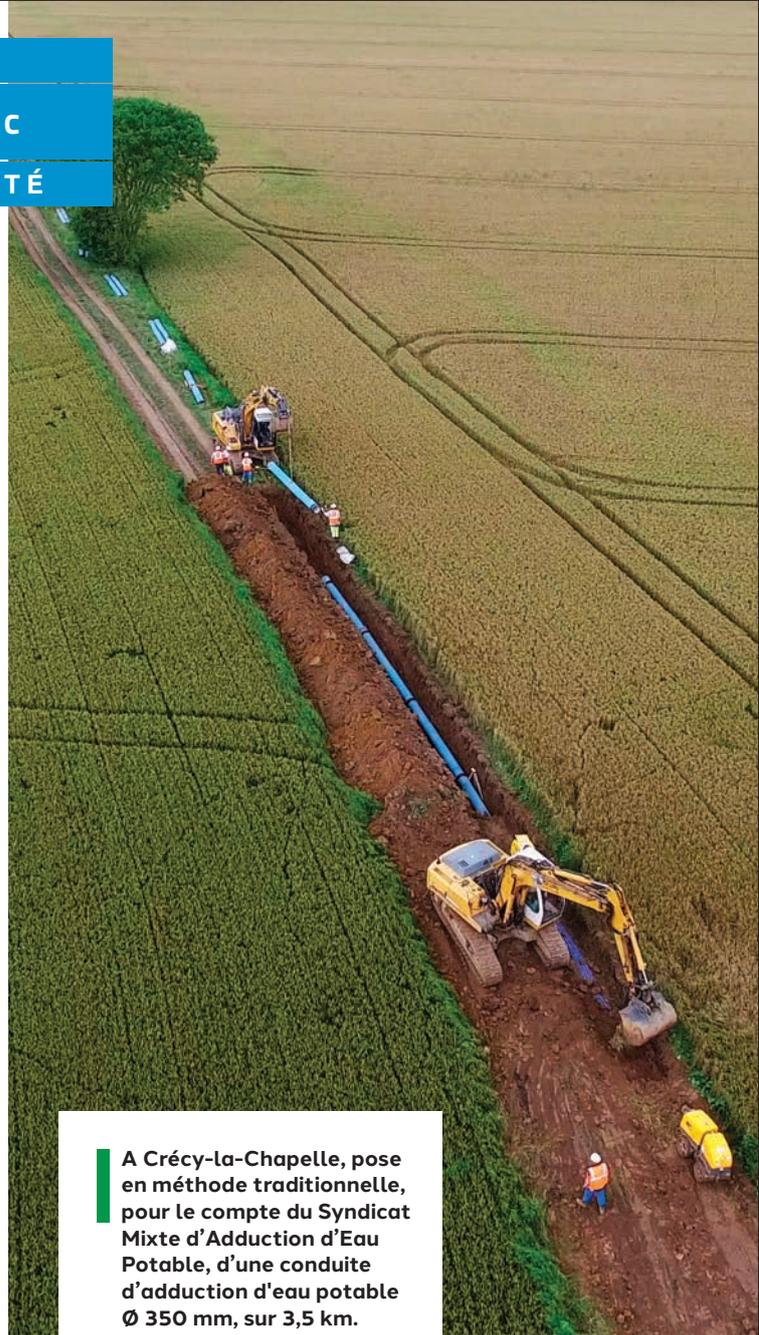
A Crécy-la-Chapelle, pose en méthode traditionnelle, pour le compte du Syndicat Mixte d'Adduction d'Eau Potable, d'une conduite d'adduction d'eau potable Ø 350 mm, sur 3,5 km.
